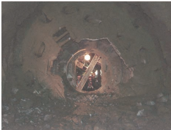
写真-4 先進坑TBM貫通
