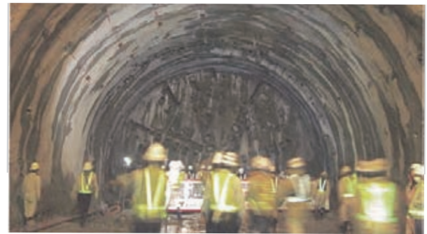
写真-5 本坑TBM貫通
