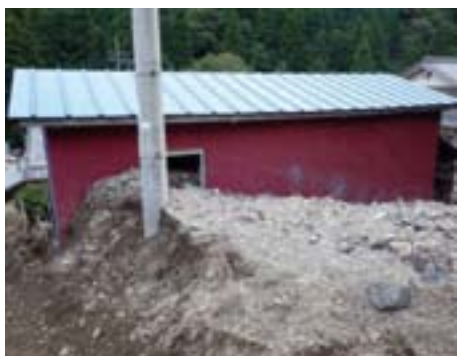
写真-3.6 未倒壊家屋
