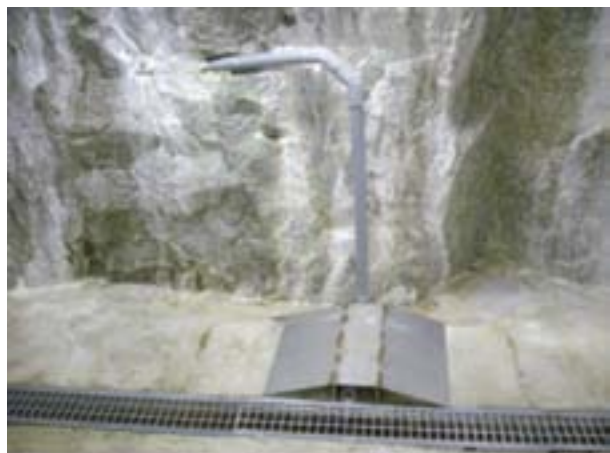
写真-2 研究用坑道の排水状況
