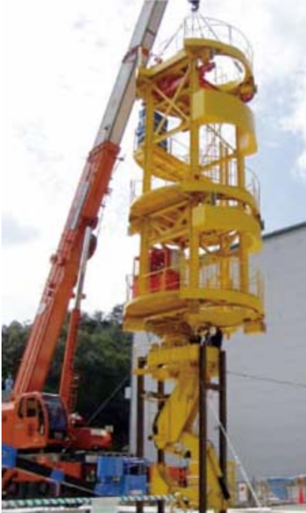
写真-1 立坑掘削用スcafford(吊り足場)
