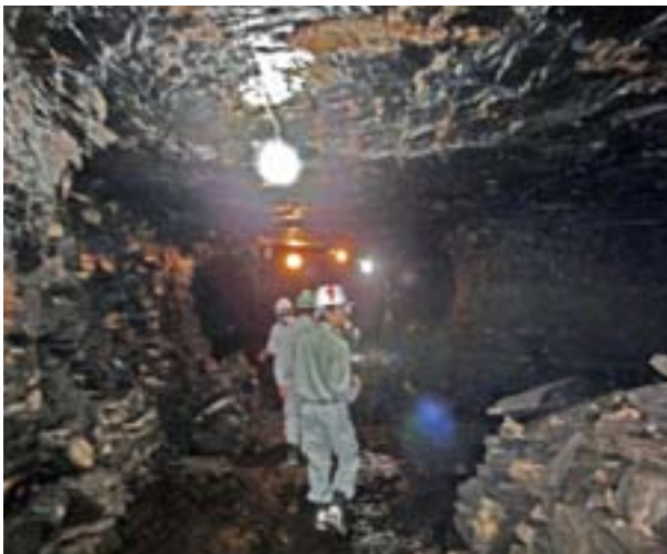
写真-2 亜炭採掘跡空洞の様子
