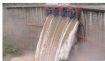
東海豪雨時(2000.9.12)の「但し書き操作」による非常用洪水吐からの放流
