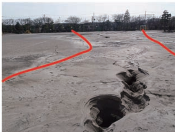
写真-3 浦安市弁天地区で帯状に発生した噴砂
