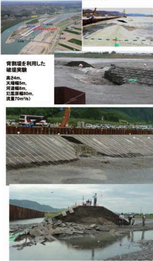
図-14 千代田実験水路での破堤実験
