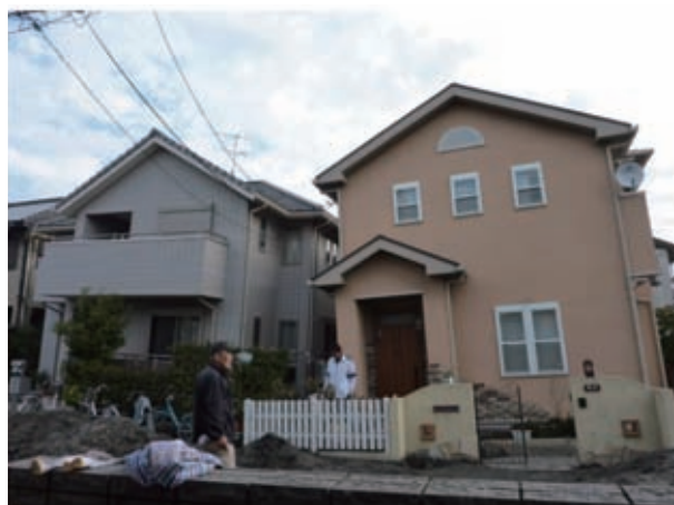
写真-2 浦安市弁天地区で発生した家屋の被害
