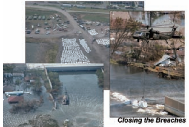
図-15 ヘリコプターで大型ブロック投入する ニューオーリンズでの破堤箇所の緊急締切(2005)
