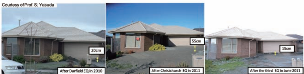
写真-1 Canterbury地震の再液状化による家屋の液状化被害と噴砂の様子 5)
