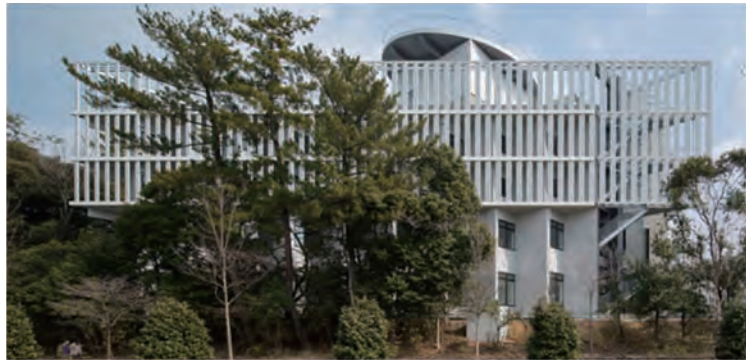
図12 減災館の西面外観
