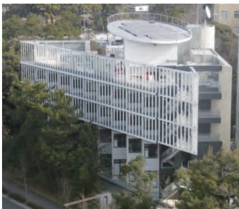
図13 減災館南面の外観
