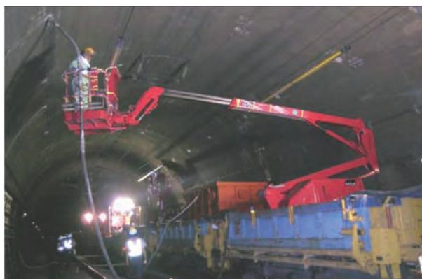
写真25 覆工裏空隙充填工
