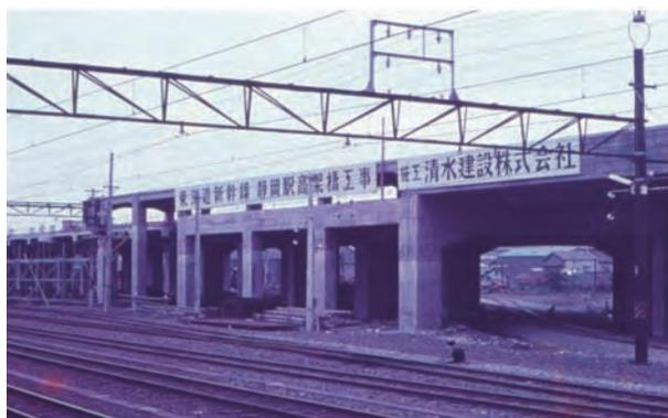
写真14 東海道新幹線建設工事の様子(静岡駅構内)
