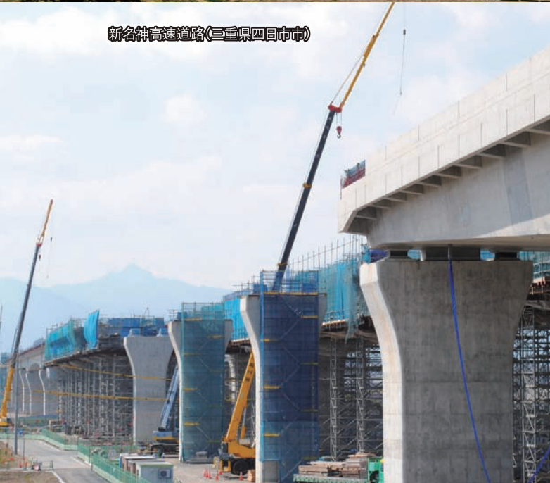
新名神高速道路(三重県四日市市)
