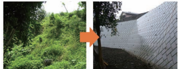
図-10 がけ地防災対策工事助成金を活用した改善
