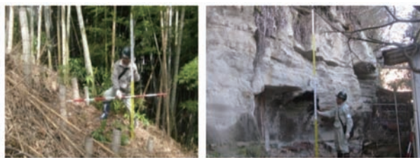
図-13 がけ地現地調査の様子
