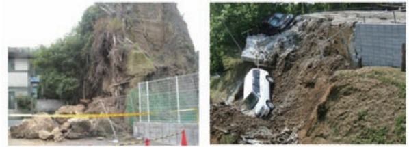
図-8 崩壊事例(左:切土斜面,右:CB盛土)
