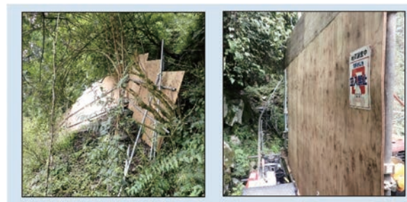
図-3.1 落石を対象とした安全対策
