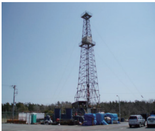
写真-2.1 深井戸全景
