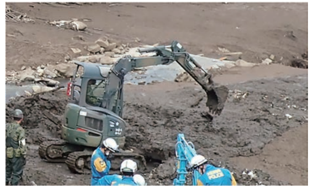
図-2.1.2 泥流を掘削撤去している状況
