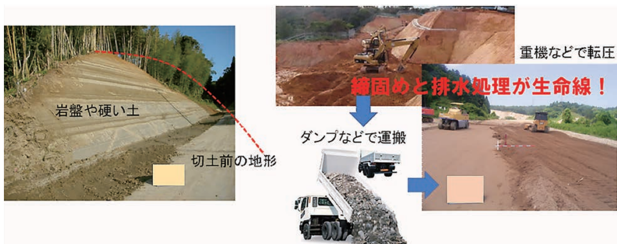
図-2.3.1 宅地造成時の切土と盛土の特徴
