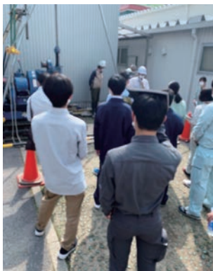
ボーリング作業見学会の状況
