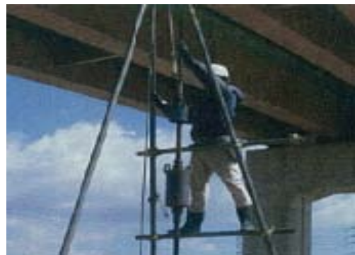
写真-1 現状の高所作業状況
