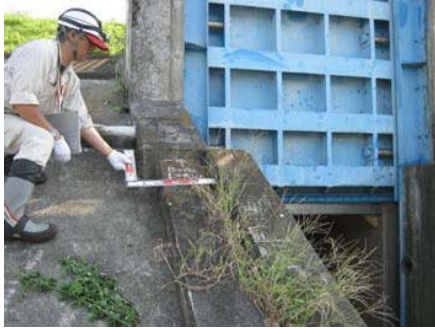
写真-1 外観調査状況
