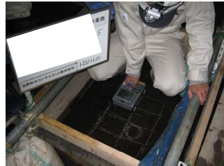
写真-3 鉄筋探査状況
