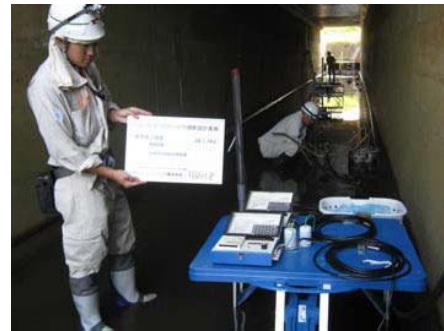
写真-4 連通試験状況
