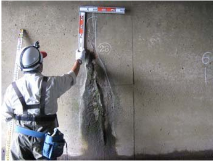
写真-2 函内調査状況
