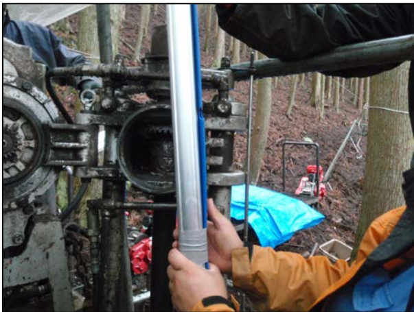
写真-2 フラットホース取り付け先端部
