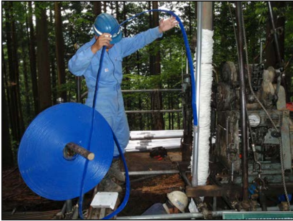
写真-1 フラットホース使用時の挿入状況
