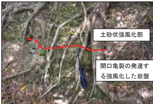
写真-1 土砂状強風化部と開口亀裂の発達する岩盤の境
