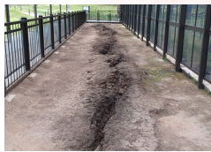
地表地震断層
