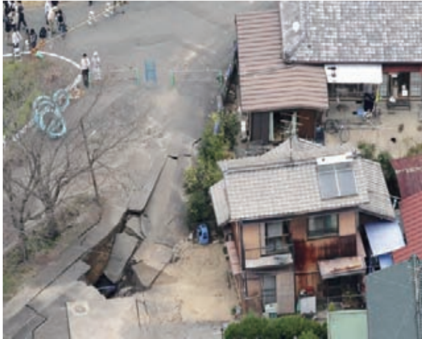
図-4.6 岐阜県御嵩町の陥没の状況 6)
