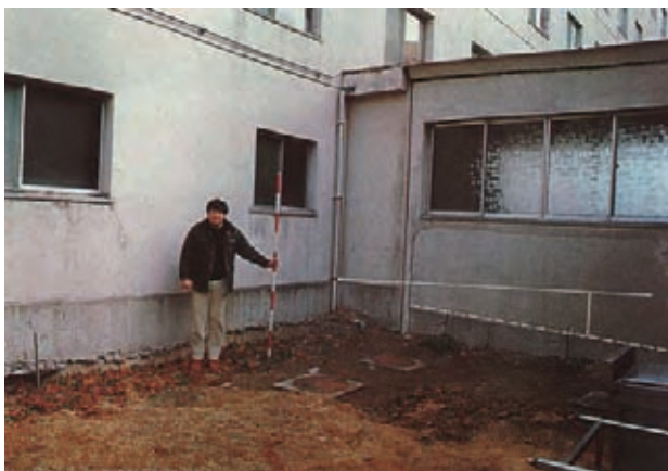
図-4.4 異種基礎での不等沈下 3)
