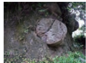
図 -9.3 花崗斑岩の核岩面での落石に対して留意を必要とする。
