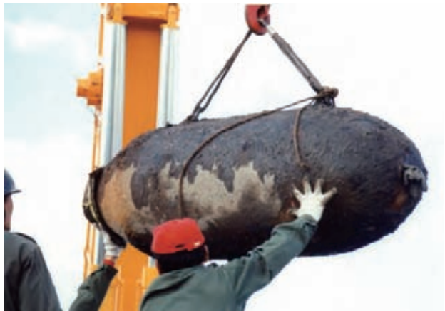
図-5.13 不発弾処理の状況(1トン爆弾)(日本物理探鑑(株)提供)
