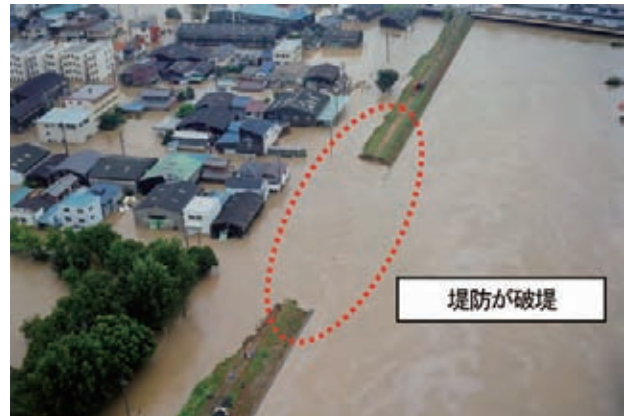
図-4.1 東海豪雨による新川左岸堤防の破堤(文献1)に加筆
