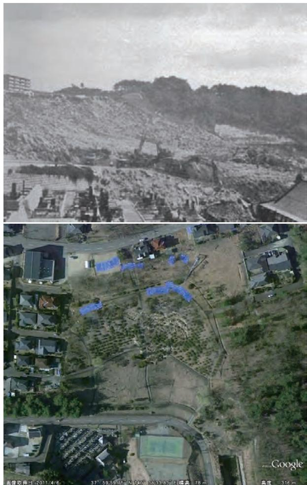
写真-1.2 谷埋め盛土崩壊(1978年宮城県沖地震
