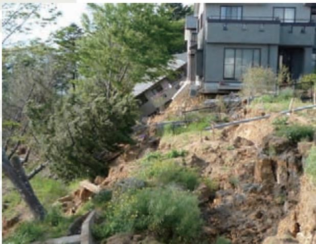
写真-1.1 仙台市での盛土崩壊例その1
