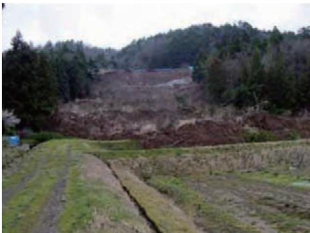
写真-5.1 崩壊後の対象谷埋め盛土斜面
