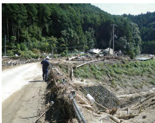
図-10 土石流による被害状況
