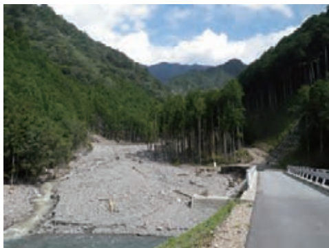
図-27 松原谷川との合流地点付近の状況 および治山堰堤の状況
