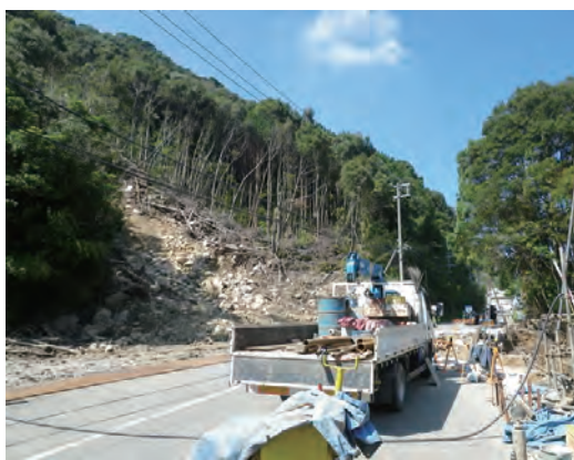
図-11 斜面の崩壊状況
