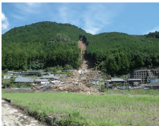
図-9 斜面の崩壊状況
