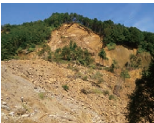
図-12 斜面の崩壊状況
