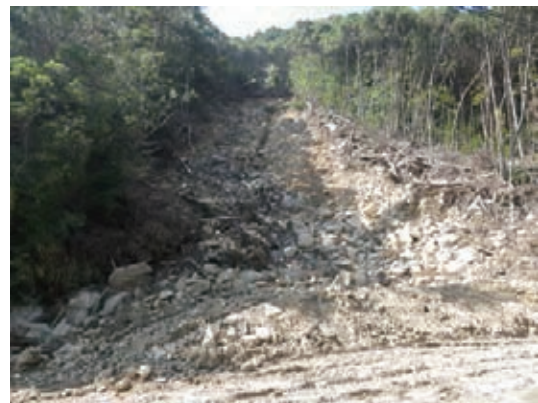
図-40 紀宝町周辺の崩壊状況（神内）
