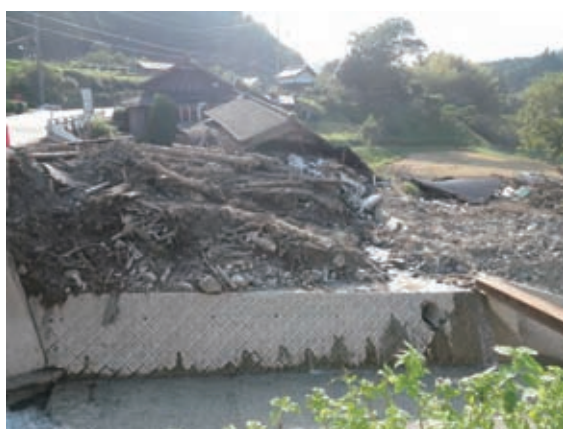
図-22 土石流による被害状況
