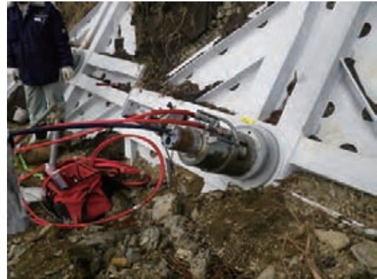
図-53 SAAM ジャッキによるリフトオフ試験
