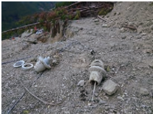
図-52 破断したアンカーの状況
