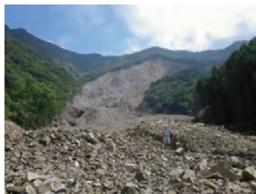
図-25 源頭部の崩壊状況と土砂の堆積状況
