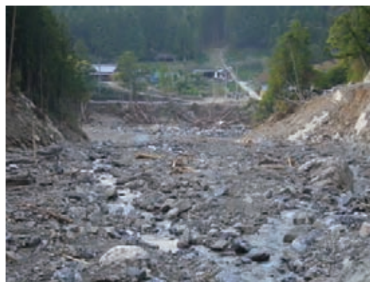
図-31 堰堤の崩壊と向岸の状況
