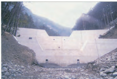
図 -46 被災前の治山堰堤の状況 (三重県松阪農林商工環境事務所提供)
