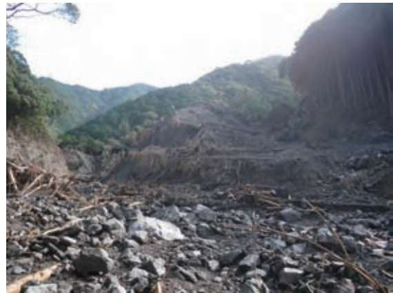
図-19 土砂の堆積状況
