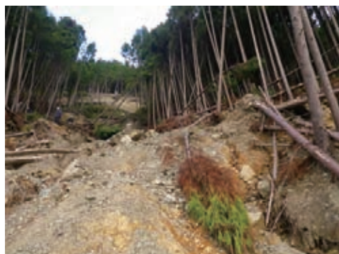
図-32 源頭部の崩壊状況
