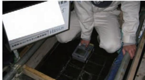
写真-3 鉄筋探査状況
