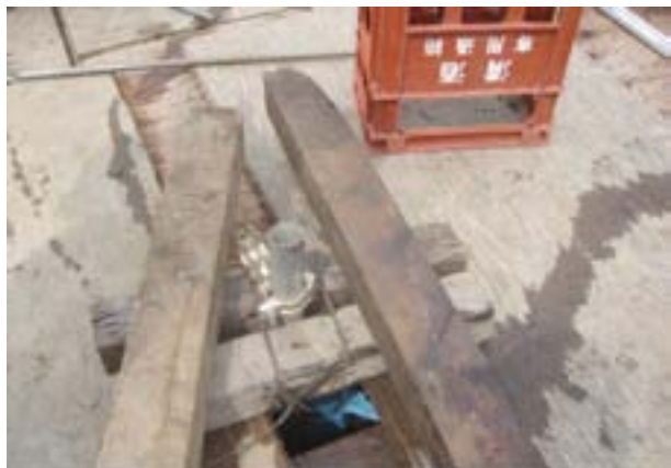
写真-2 ガイドパイプ設置
