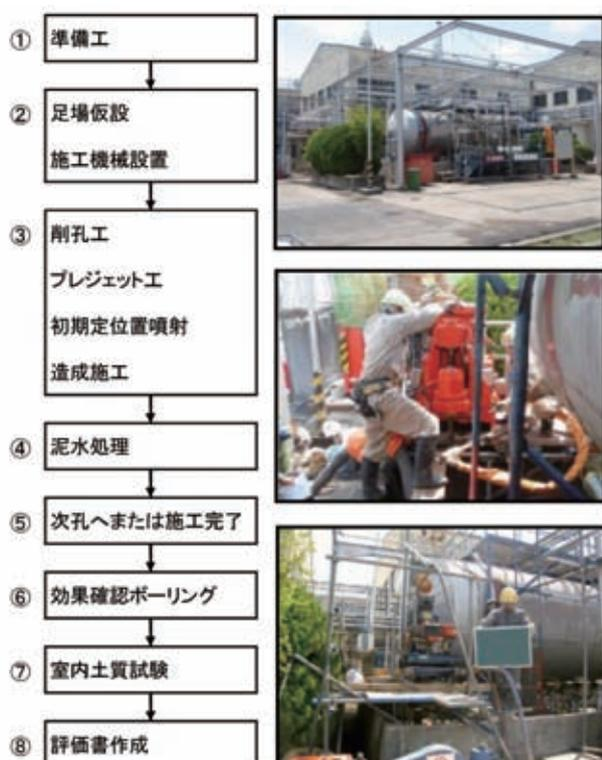
図-5 工事の流れ図と工事中写真
