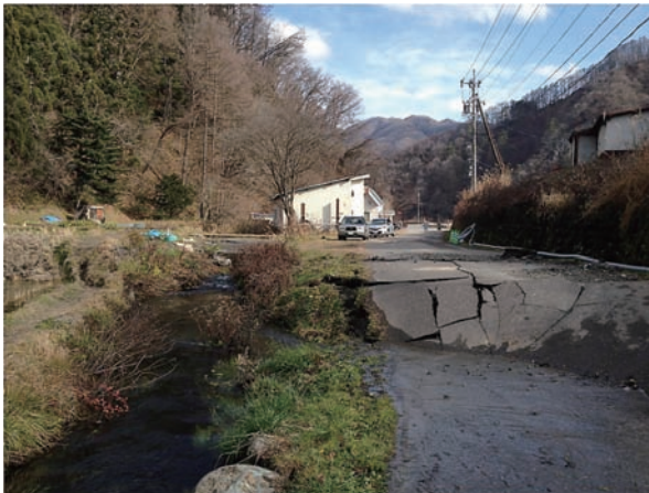
写真-3 2014年長野県北部の地震で出現した地表地震断層 (長野県白馬村)
