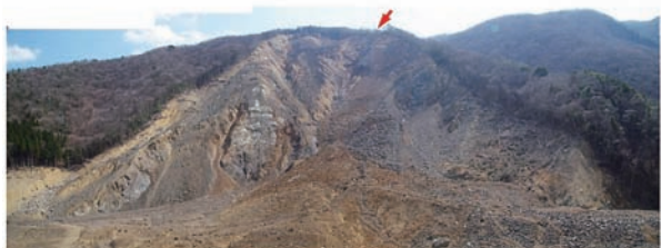
図-4.1.1 赤谷崩壊 矢印で示されたところから下が、すべり面に転化したもとのスラスト面
