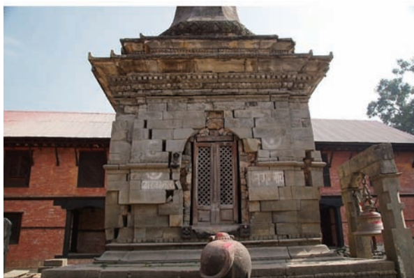
図-3.2 カトマンズ、パシュパティナート寺院の石塔の変形
