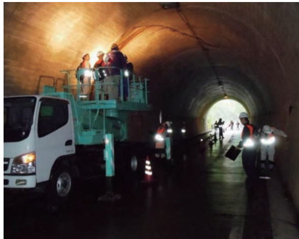
図-3.2.4 フィールド実習の様子 (トンネルの点検)
