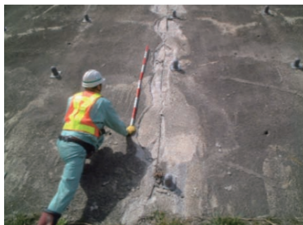
図-4.3.4 付帯施設の例(コンクリート吹付)
