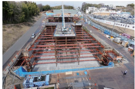
写真-1.3.4 開削工法のトンネル例⑨
