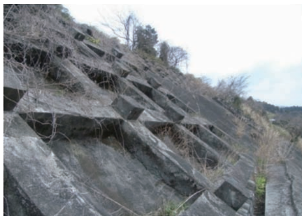
図-4.3.3 付帯施設の例(コンクリート枠)
