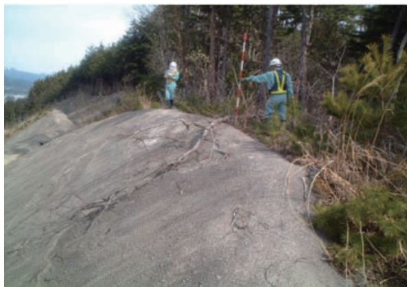
図-4.3.1 切土のり面の点検
