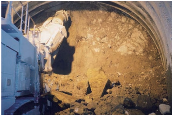
写真-1.3.2 NATMのトンネル例⑦
