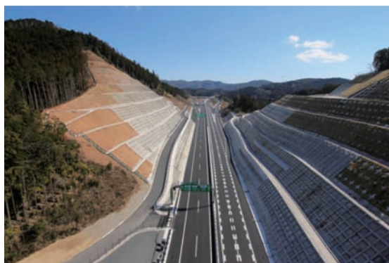
図-6.2.1 新東名高速道路の切土のり面
