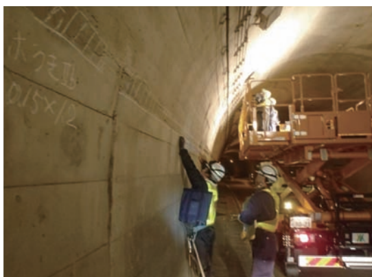
写真-2.2.1 近接目視 13)
