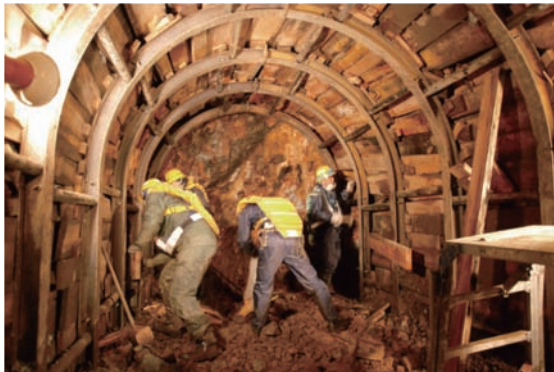
写真-1.3.1 矢板工法のトンネル例⑥
