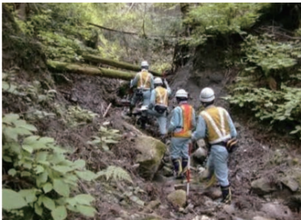
図-4.3.2 自然斜面等の点検
