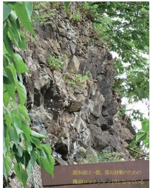
写真-6 柱状節理(縦約2.0m×横2.5m範囲で露出)
