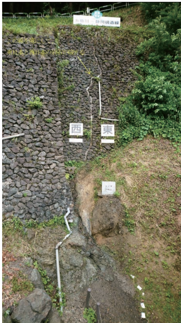
写真-4 人工的に露出させた糸魚川-静岡構造線
