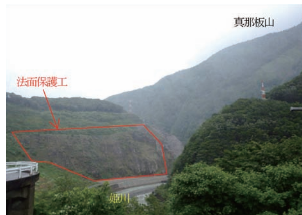
写真-3 姫川沿いの大規模地滑りに対する法面保護工
