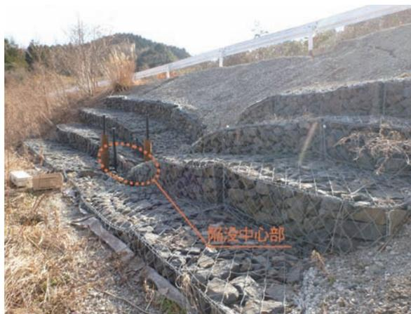
写真-2.1 陥没中心部の状況
