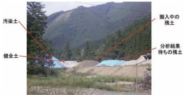
写真-2.2.2 トンネル掘削残土仮置きの様子
