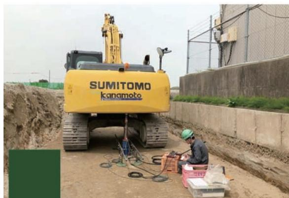
写真-4.2 平板載荷試験
