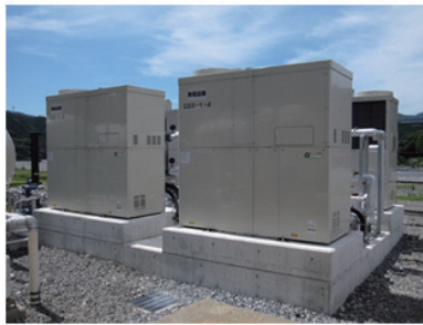
ガスエンジン発電機 (25 kW x 4基)
