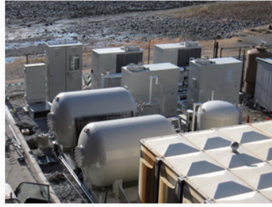
ガス保存用タンクと ガスエンジン発電機
