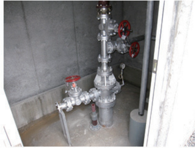
温泉用掘削井 (深度1,148メートル)
