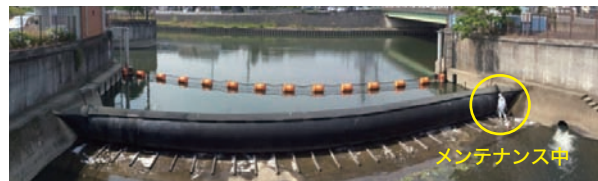
写真-26 古庄分流堰(ゴム堰)
