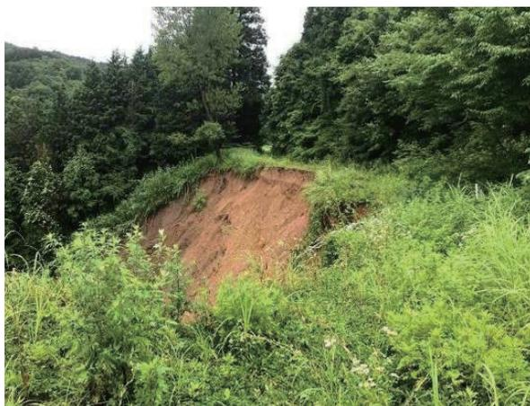
図-7 作業道の切り盛り境からの崩壊箇所
