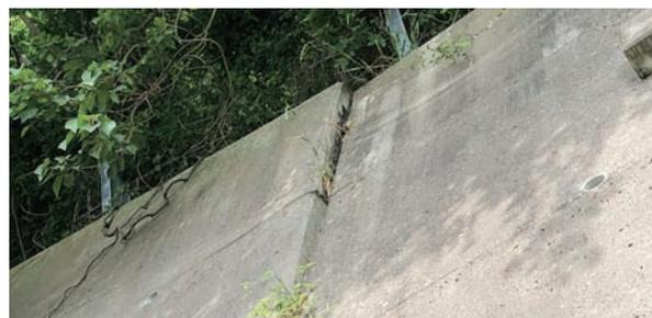
写真-4 末端部擁壁のズレ
