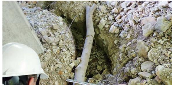
写真-2 鉄塔基礎付近の変状
