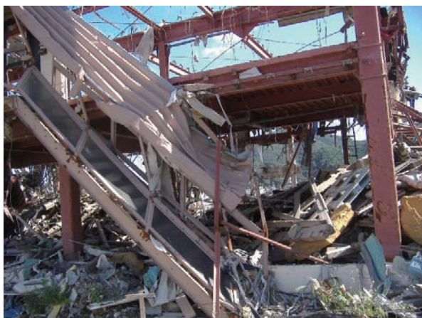
写真-2 平成23年(2011年)東北地方太平洋沖地震の津波で破壊された建物(宮城県内 撮影：応用地質(株))
