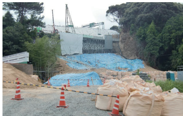
写真-7 2009.8東名高速道路牧之原付近盛土のり面の崩壊復旧工事(東名高速道路4日間の通行止め)
