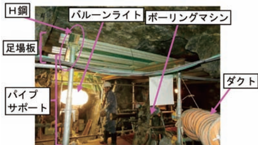
写真-2 ポーリング作業箇所の仮設備状況
