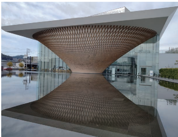
写真-2.1 静岡県富士山世界遺産センター外観
