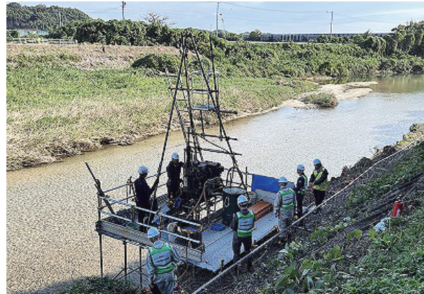
写真-4.1 安全パトロール
