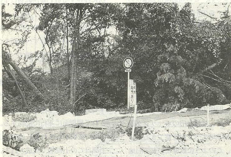
写真-14 滑落崖直下に40m落下した道路、この先段差ありの標識は皮肉
