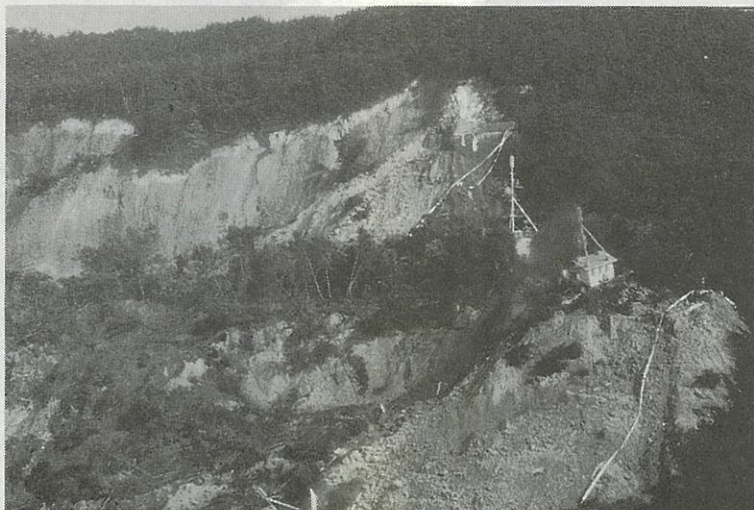
写真-13 地すべり地北端の滑落崖
