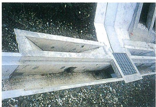
写真-13 環境側溝の設置状況
