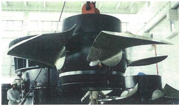
図-11 湛水被害防止の排水機場建設工事における立軸軸流ポンプ設置
