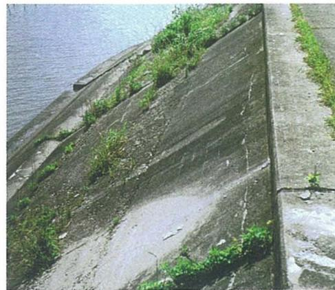
写真-1 老朽化した海岸堤防
