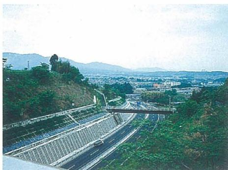
写真-2 中津川国道19号バイパスのり面对策工
